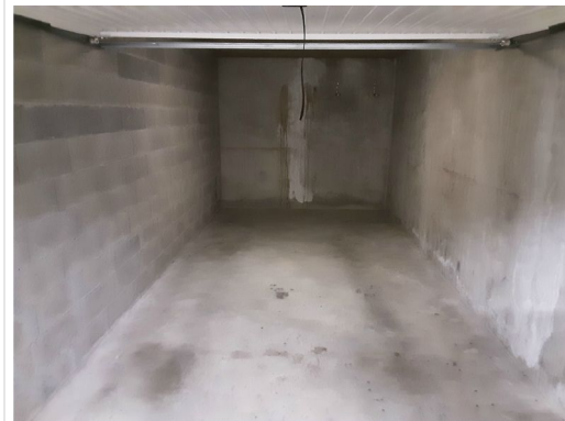
GARAGE / BOX N° : 26
